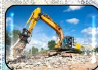
車両系建設機械(解体)
